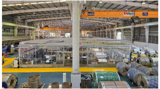
（PSCTH 生产车间全景）
